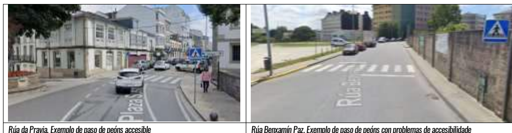
Rúa da Pravia. Exemplo de paso de peóns accesible
