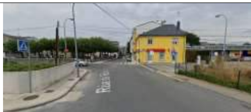
Rúa Ribadeo. Zona de equipamentos con problemas de accesibilidade en beirarrúas
