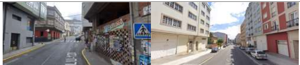
Avenida da Terra Chá. Zona máis próxima ó centro con problemas de accesibilidade
